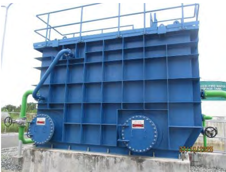
ระบบแยกน้ำ-น้ำมัน (Oil Water Separated)
